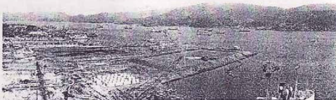
ビトン港コンテナ埠頭工事全景 2002年 10月 24日
