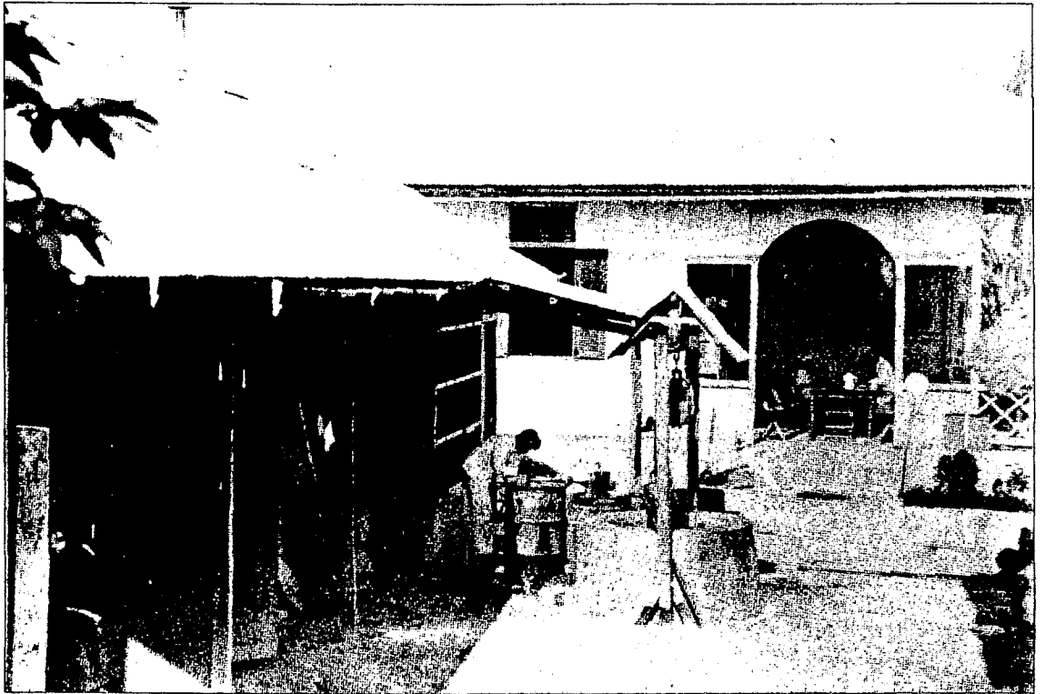
養殖場には多い時で18人の日本人が暮らしていた。写真内の左は炊事場、奥は食堂。潮水の混った井戸水は生活用水に使用
